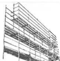
Ponteggio metallico fisso
