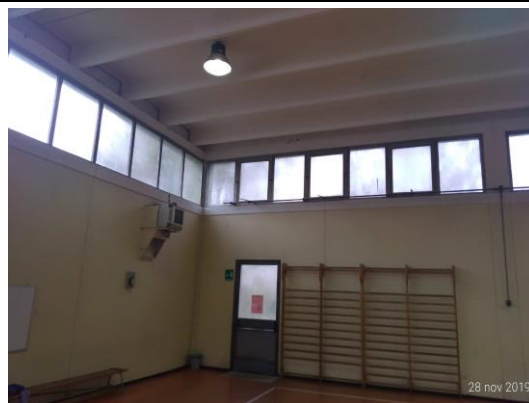
Palestra serramenti esistenti
