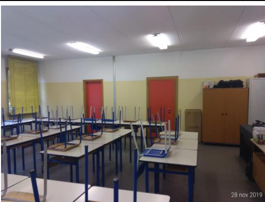
Classe tipo serramenti interni esistenti
