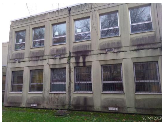
Facciata tipo scuola Secondaria di Redecesio
