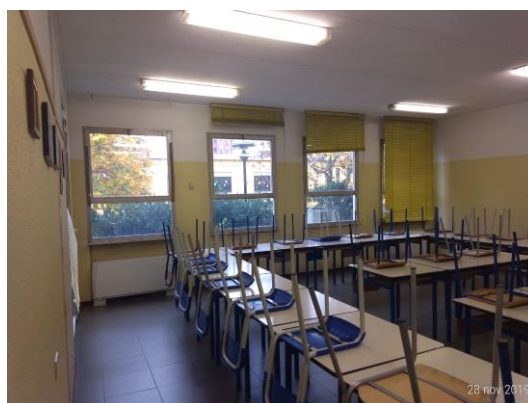
Classe tipo serramenti esterni e veneziane esistenti
